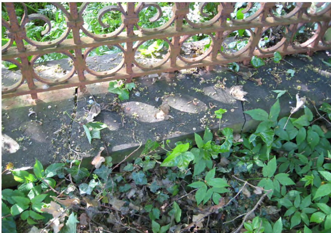
foto 66: Gescheurde hardstenen afdekbanden onder het hekwerk.
