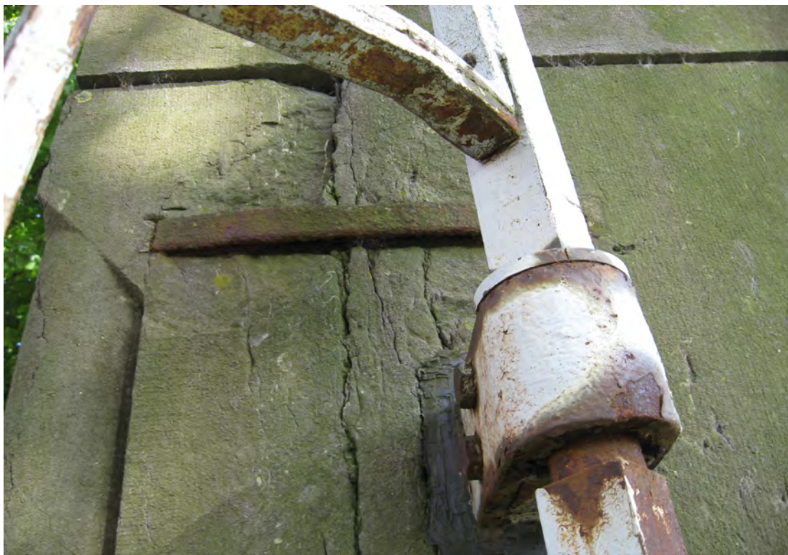
foto 48: Scheur in de hardstenen kolom. De ijzeren kram is ernstig gecorrodeerd.
