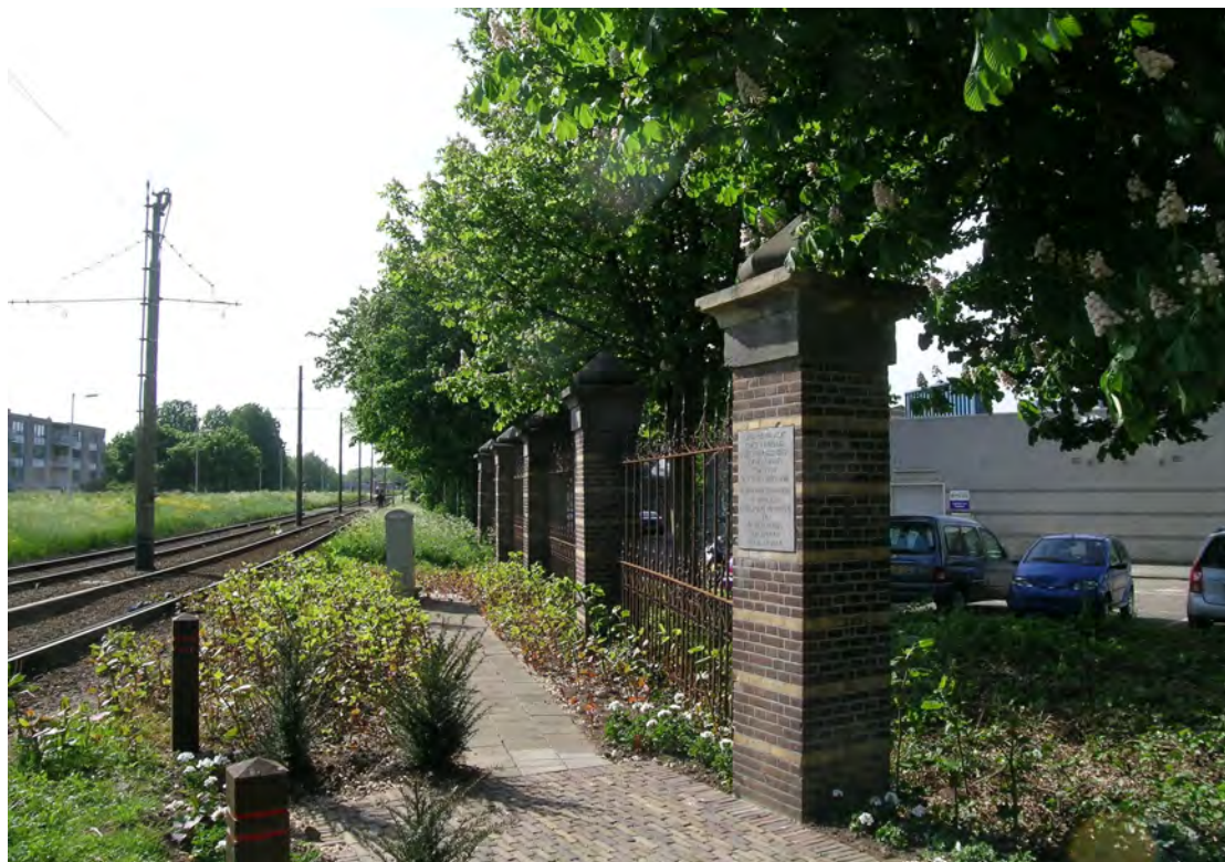
foto 10 : De kolom aan het begin van het hek staat gedraaid ten opzichte van het hek. (Zie ook de herdenkingsplaquette in de gemetselde kolom)
