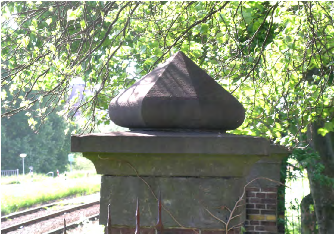
foto 79: Aanzicht van een hardstenen afdekking van een gemetselde kolom.
