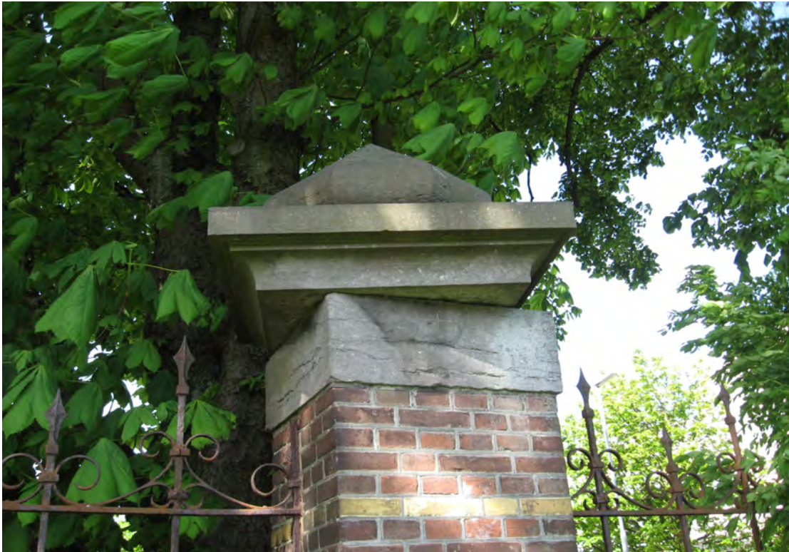
foto 13 : Verschoven hardstenen afdekking op een gemetselde kolom
