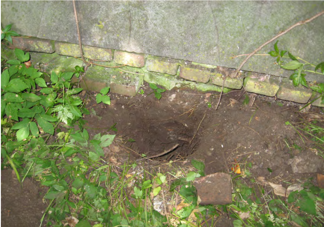
foto 73: De gemetselde fundering onder de hardstenen plint t.p.v een gemetselde kolom.
