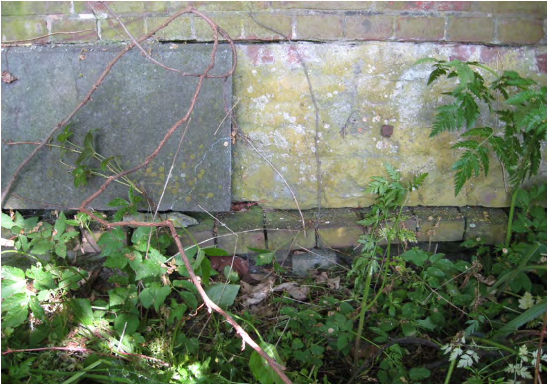
foto 71: De hardstenen plint t.p.v een gemetselde kolom is plaatselijk niet meer aanwezig.
