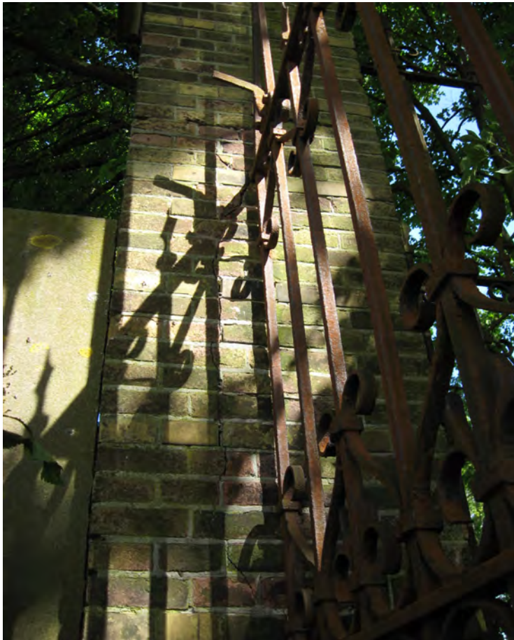
foto 43: Door het corroderen van het ingemetselde ijzerwerk zijn er scheuren ontstaan in het metselwerk.
