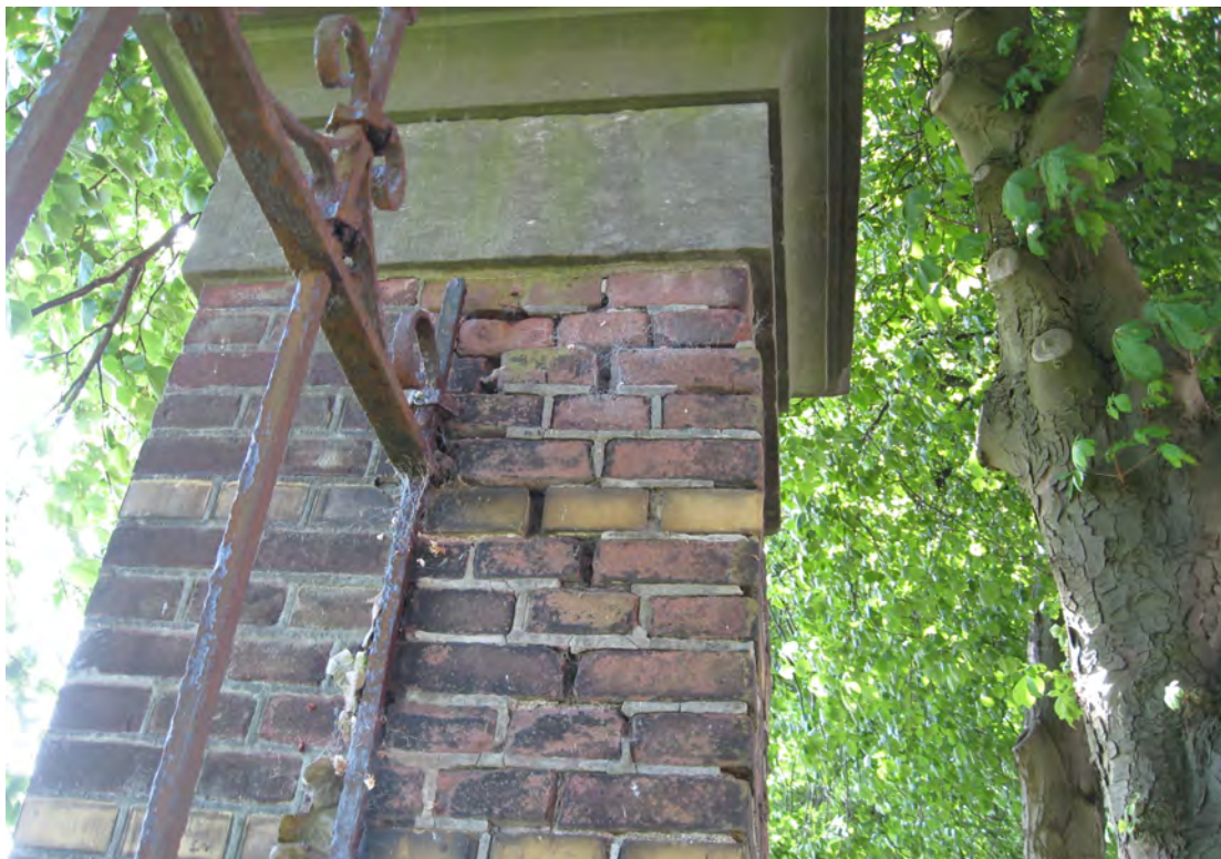
foto 31: Gemetselde kolom waarbij duidelijk zichtbaar is dat de kolom aan de trambaanzijde in redelijke staat is en aan de andere zijde slechter van kwaliteit is.
