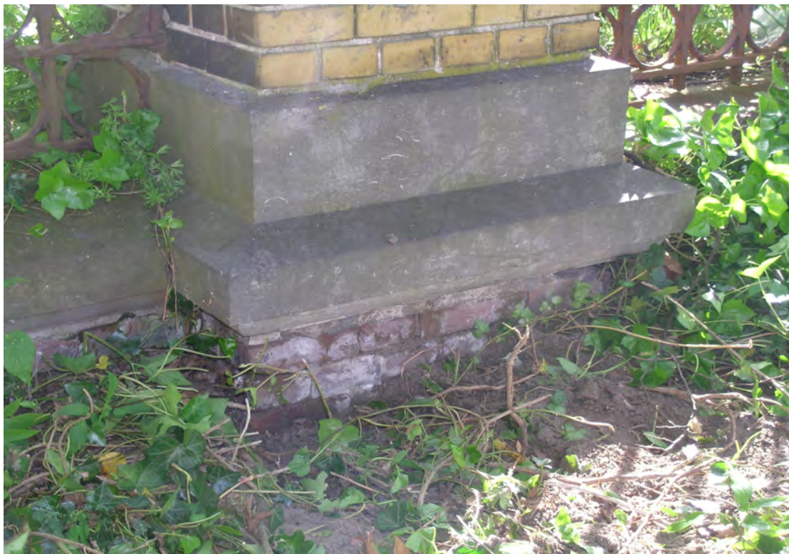
foto 80: Aanzicht van een hardstenen plint en afdekband t.p.v. een gemetselde kolom.
