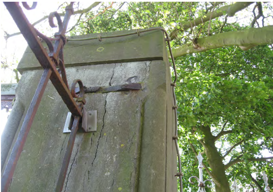
Foto 44: Scheuren in de hardstenen kolommen. De ijzeren kram is ernstig gecorrodeerd.
