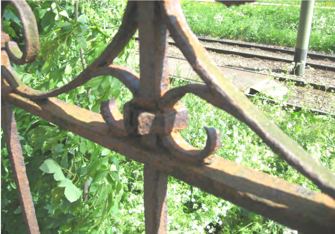
foto 59: Het hekwerk is ernstig door corrosie aangetast, de ijzeren verbindingen zijn gecorrodeerd.
