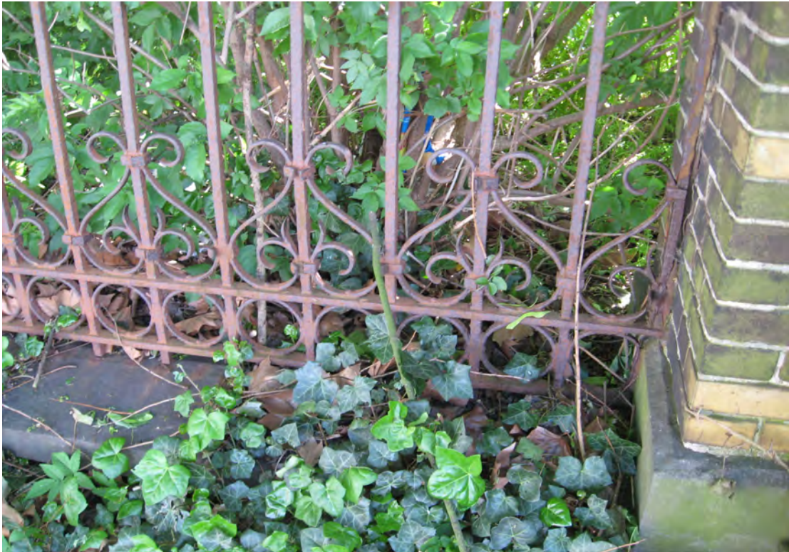
foto 53: Het hekwerk is ernstig door corrosie aangetast.
