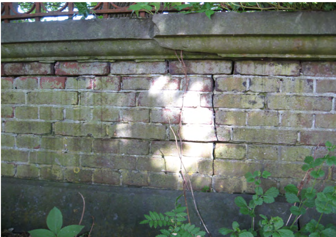
foto 68: Slecht voegwerk en scheurvorming van het metselwerk onder de hardstenen afdekbanden.
