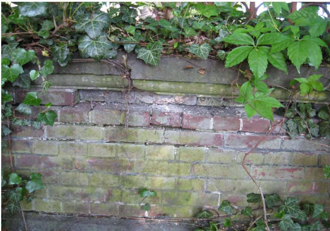
foto 70: Slecht metselwerk onder de hardstenen afdekbanden.
