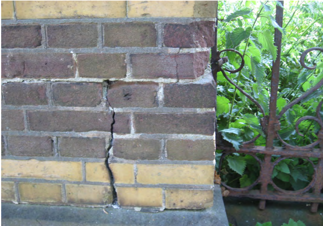
Foto 41: Scheur in het metselwerk.
