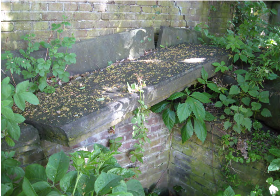
foto 69: Beschadigde hardstenen afdekbanden a.g.v. bomen.
