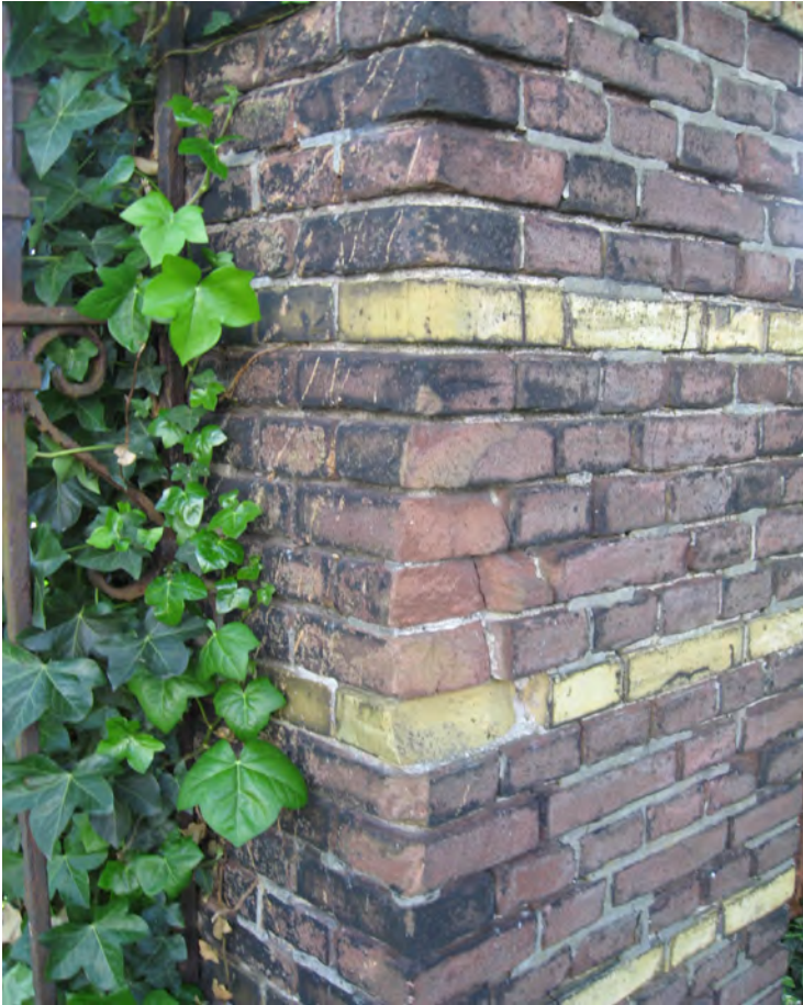
foto 27 : Gemetselde kolom van slechte kwaliteit (slecht voegwerk en metselwerk).
