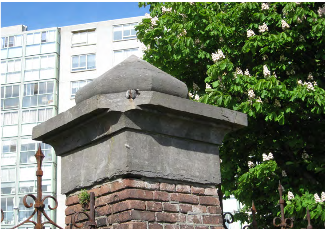
foto 14 : Beschadigde hardstenen afdekking op een gemetselde kolom
