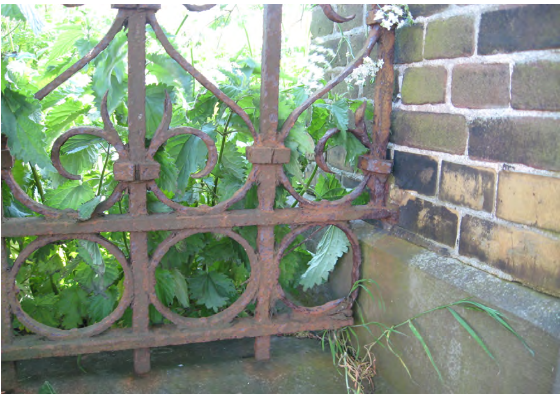
foto 56: Het hekwerk is ernstig door corrosie aangetast.
