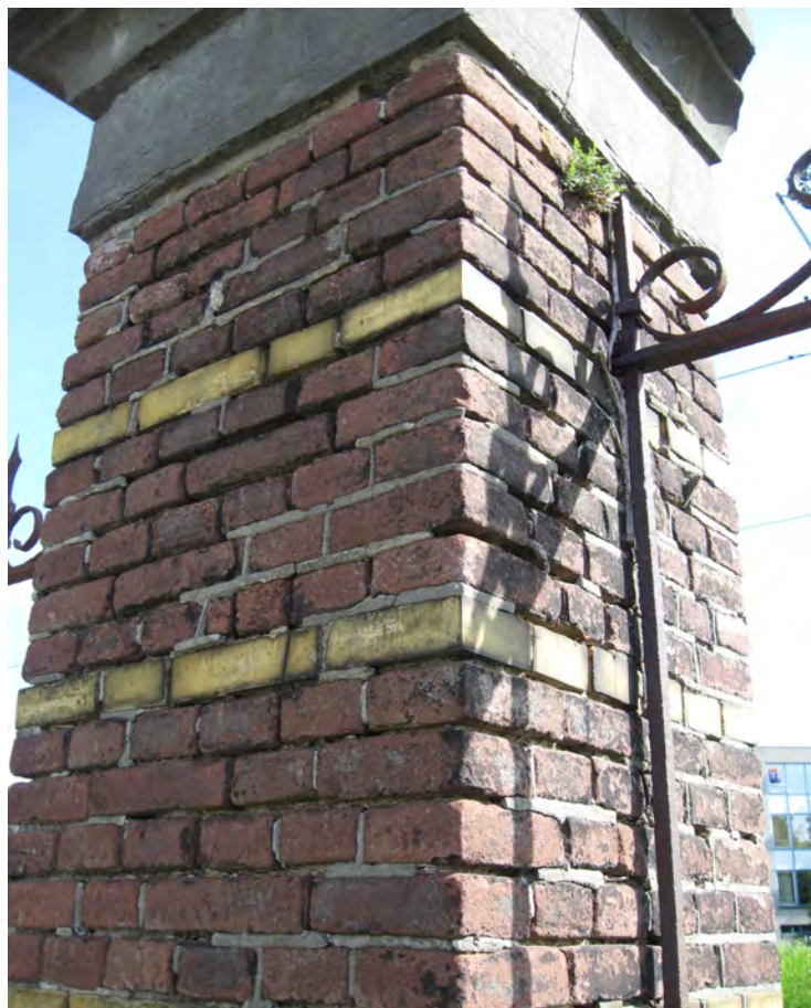
foto 24 : Gemetselde kolom van slechte kwaliteit (scheurvorming, slecht voegwerk en metselwerk).
