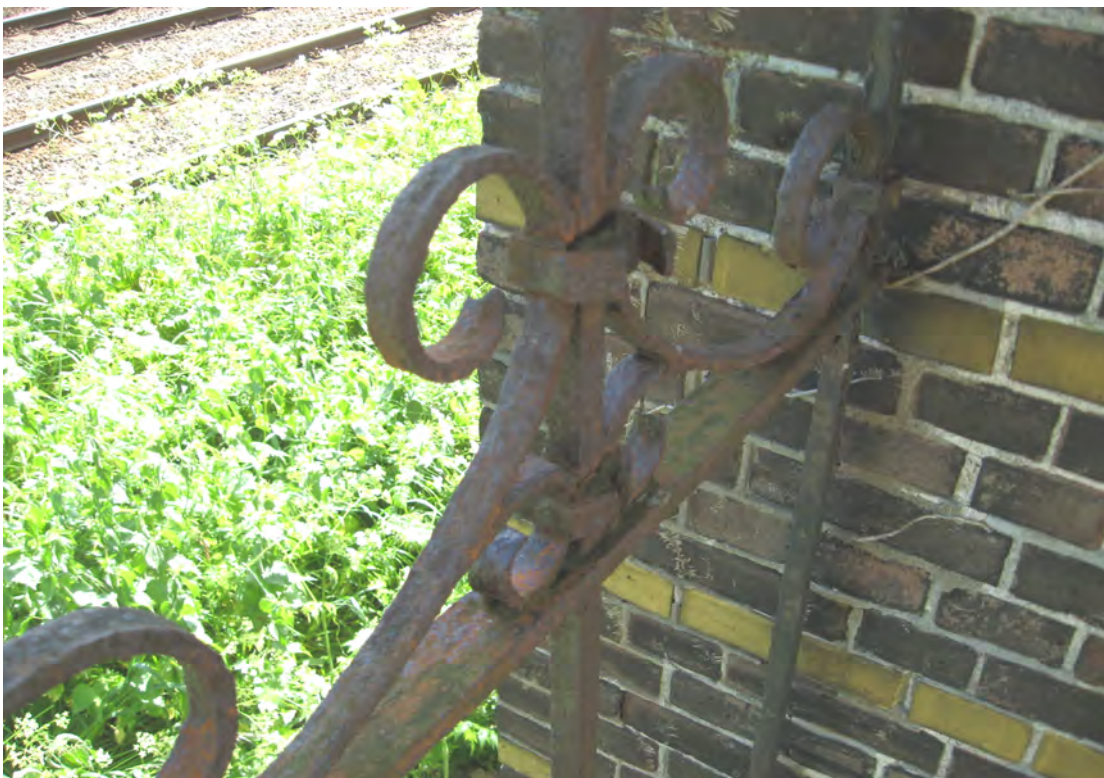
foto 60: Het hekwerk is ernstig door corrosie aangetast, de ijzeren verbindingen zijn gecorrodeerd.
