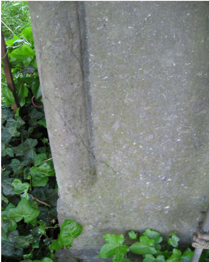
foto 45: Scheur in de hardstenen kolom.
