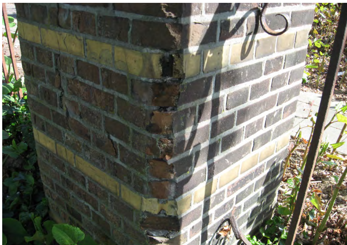
foto 20: Beschadigd metselwerk van een gemetselde kolom
