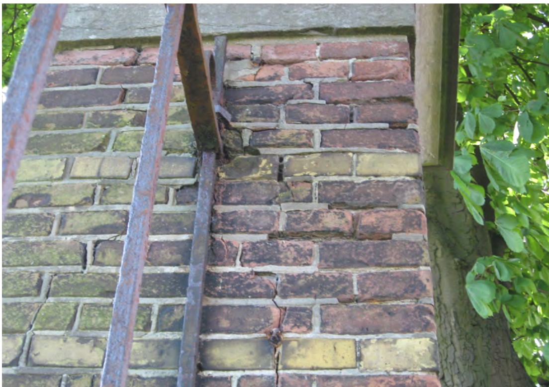
Foto 36: Door het corroderen van het ingemetselde ijzerwerk is het metselwerk gaan scheuren.
