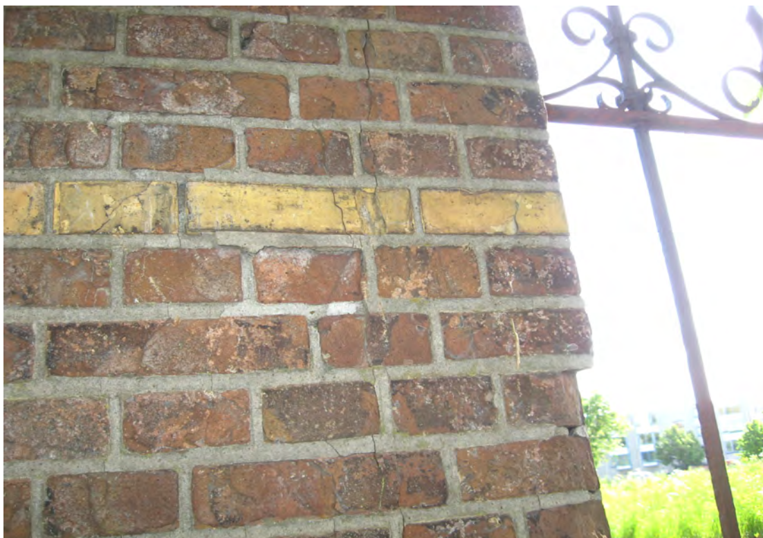
foto 19 : Beschadigd metselwerk van een gemetselde kolom.
