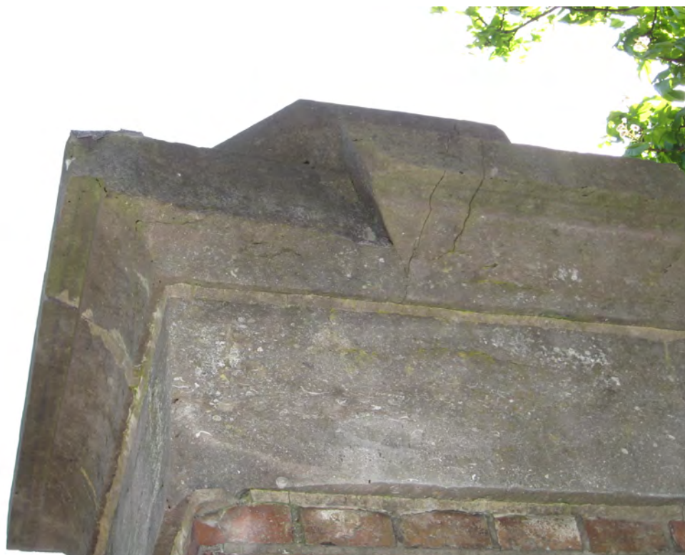
foto 16 : Beschadigde hardstenen afdekking op een gemetselde kolom.
