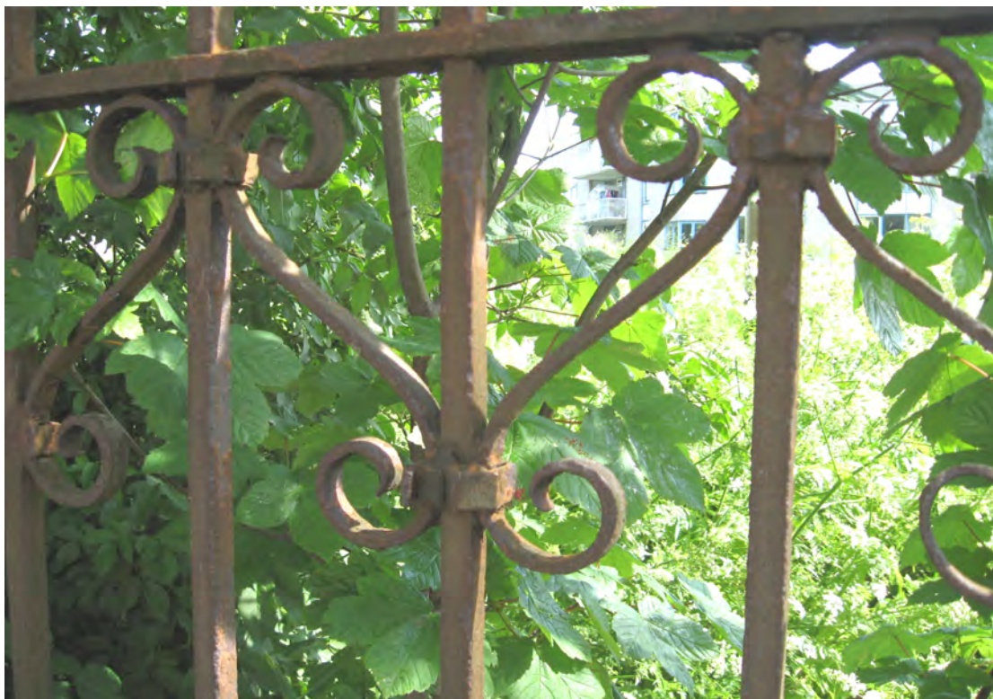
foto 62: Het hekwerk is ernstig door corrosie aangetast, de ijzeren verbindingen zijn gecorrodeerd.
