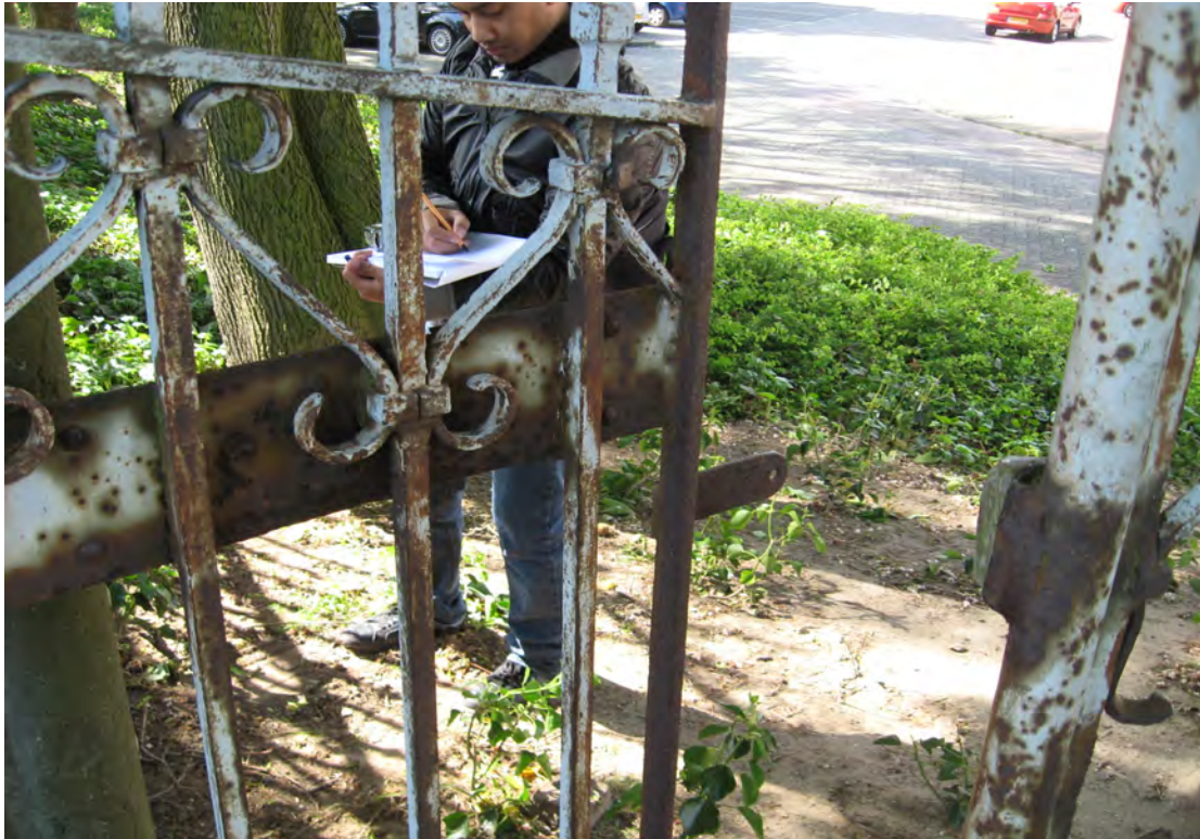
foto 49: Het draaihek tussen de hardstenen kolommen dat sterk is aangetast door corrosie.
