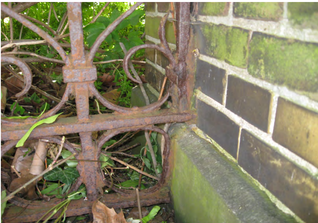
foto 54: Het hekwerk is ernstig door corrosie aangetast.
