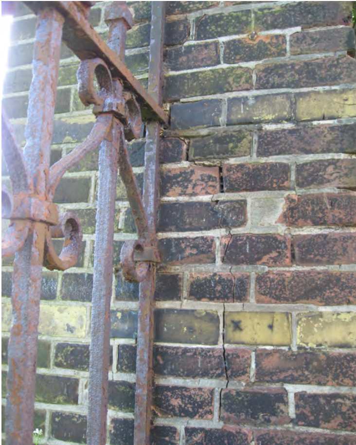
foto 37: Door het corroderen van het ingemetselde ijzerwerk is er een scheur ontstaan in het metselwerk.
