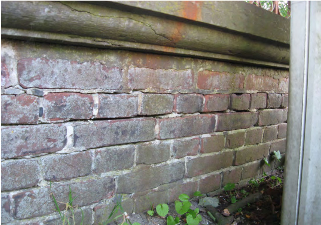
foto 67: Slecht voegwerk van het metselwerk onder de hardstenen afdekbanden.
