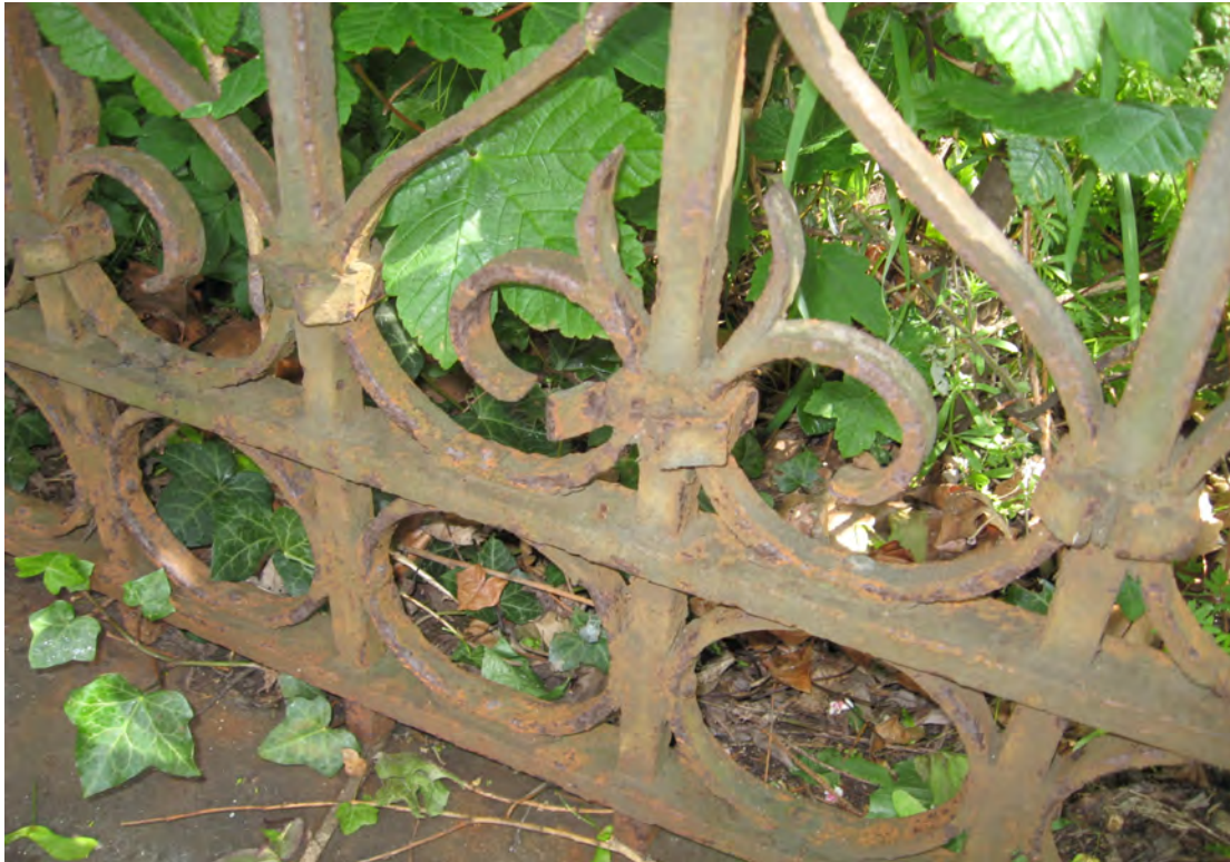
foto 63: Het hekwerk is ernstig door corrosie aangetast, de ijzeren verbindingen zijn gecorrodeerd.
