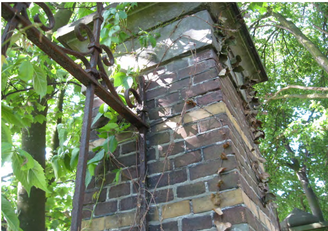
Foto 42: Door het corroderen van het ingemetselde ijzerwerk is het metselwerk gaan scheuren.
