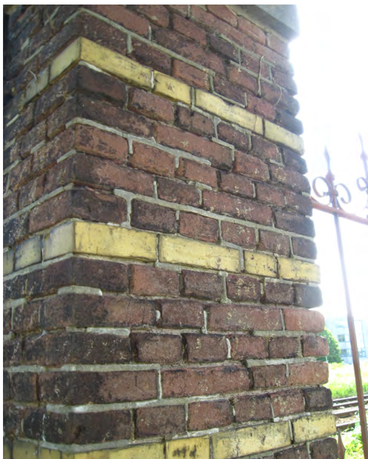
foto 21 : Scheurvorming in het metselwerk van een gemetselde kolom.
