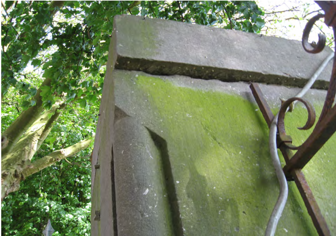
foto 47: De hardstenen afdekplaat op de kolom is verschoven.
