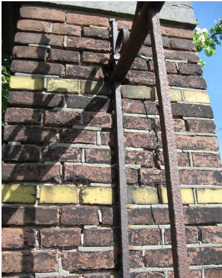
foto 23 : Gemetselde kolom van slechte kwaliteit (scheurvorming, slecht voegwerk en metselwerk).
