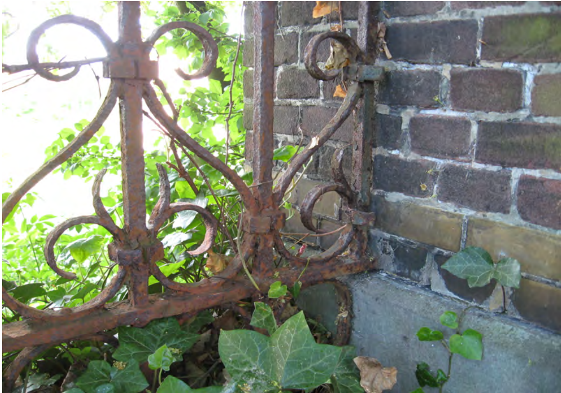
foto 61: Het hekwerk is ernstig door corrosie aangetast, de ijzeren verbindingen zijn gecorrodeerd.
