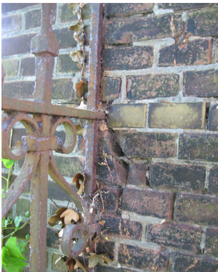
foto 31: Gemetselde kolom waarbij duidelijk zichtbaar is dat de kolom aan de trambaanzijde in redelijke staat is en aan de andere zijde slechter van kwaliteit is.
