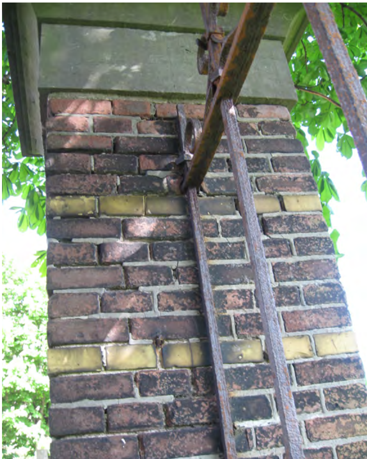
foto 28 : Gemetselde kolom waarbij het metselwerk t.p.v. het ijzerwerk los zit.
