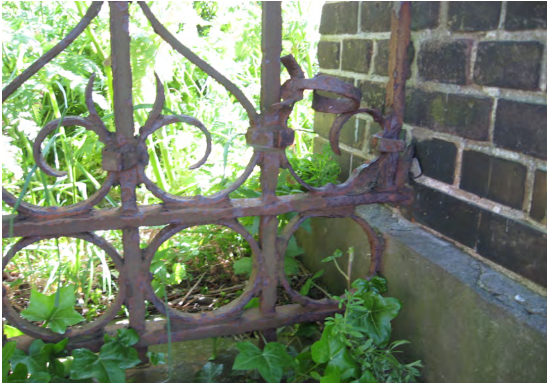
foto 55: Het hekwerk is ernstig door corrosie aangetast.
