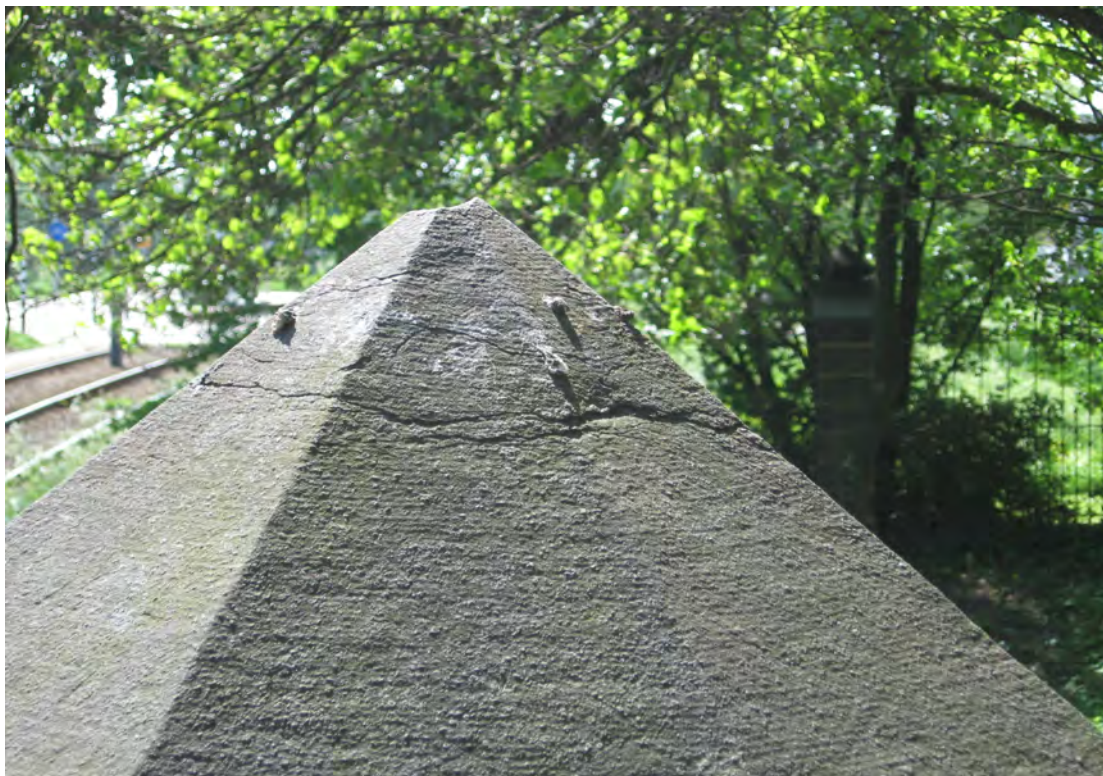
foto 17 : Beschadigde hardstenen afdekking op een gemetselde kolom.
