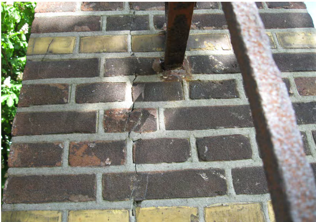
foto 21 : Scheurvorming in het metselwerk van een gemetselde kolom.
