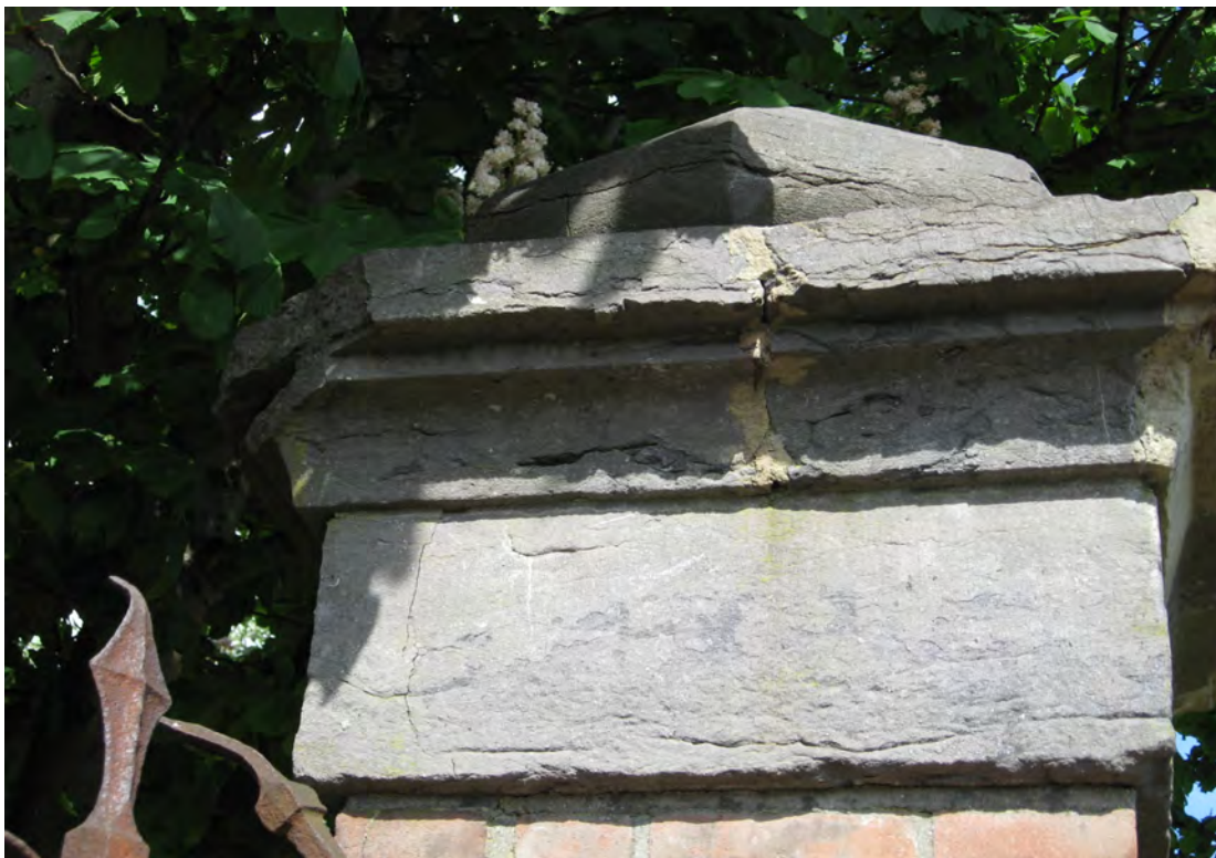
foto 15 : Beschadigde hardstenen afdekking op een gemetselde kolom.
