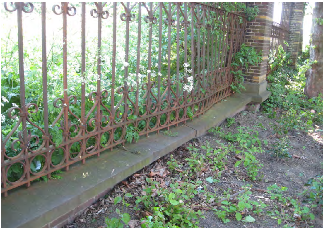
foto 64: Beschadigd hek en verschoven hardstenen afdekbanden onder het hek.
