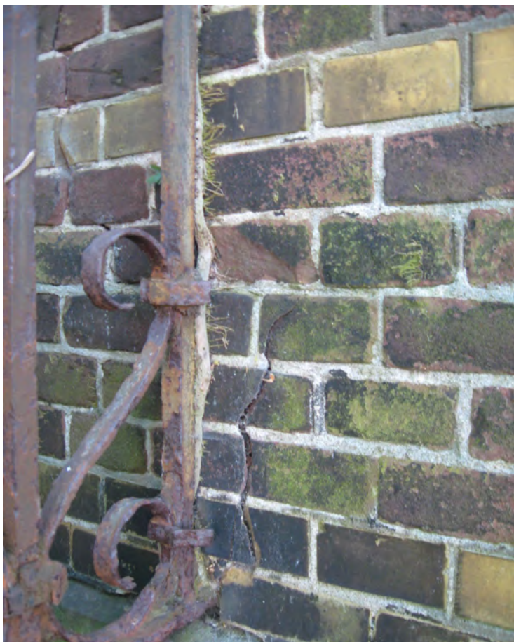
foto 40: Door het corroderen van het ingemetselde ijzerwerk zijn er scheuren ontstaan in het metselwerk.
