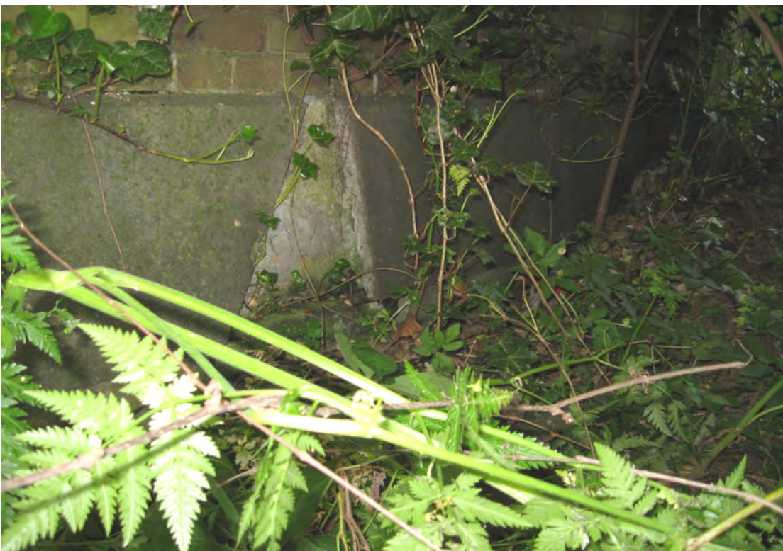
foto 72: Beschadigde hardstenen plint t.p.v een gemetselde kolom.
