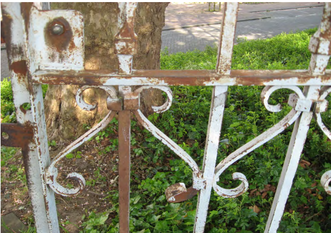
foto 50: Het draaihek tussen de hardstenen kolommen dat sterk is aangetast door corrosie.
