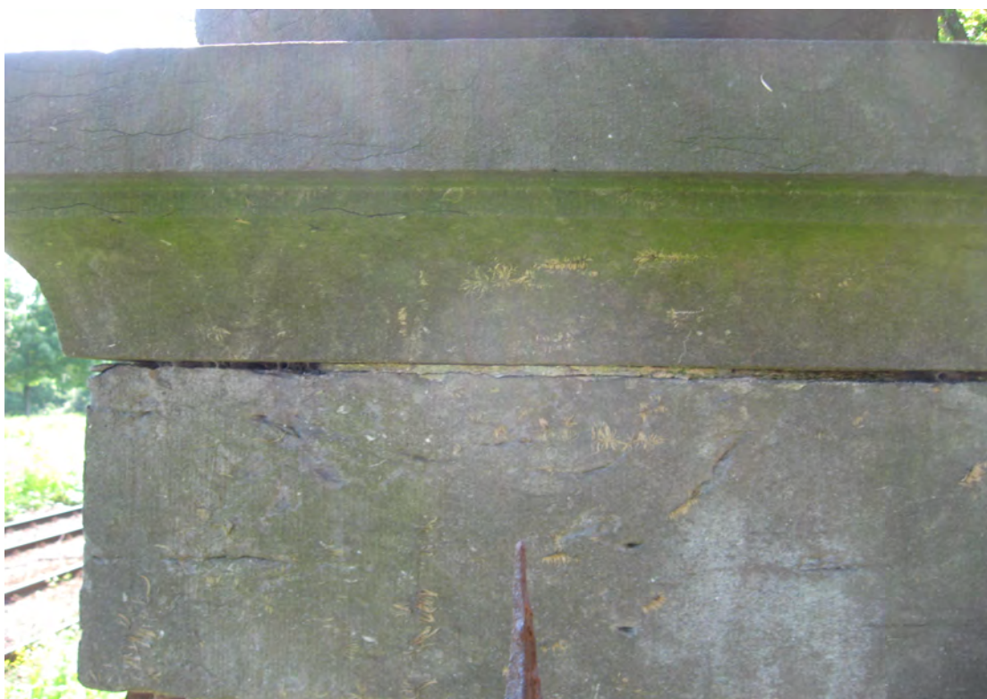
foto 18 : Open voegwerk tussen het hardsteen van de afdekking.
